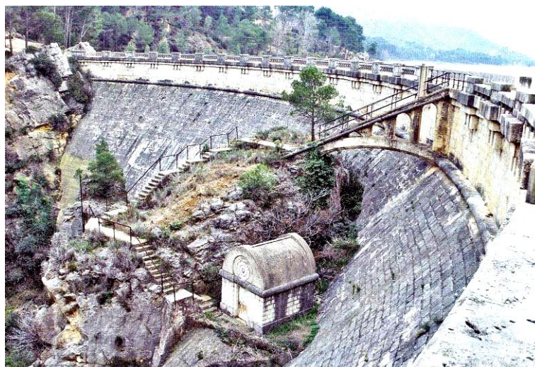
84- Presa de Buseo, vista aguas abajo con el puente peraltado a la derecha [Aguiló 2005: 198]
