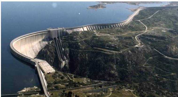
67- Presa de Almendra, vista general donde se pueden apreciar las presas laterales en las que se apoyan los estribos del muro principal [Baztán y Toledo 2008: 232]
