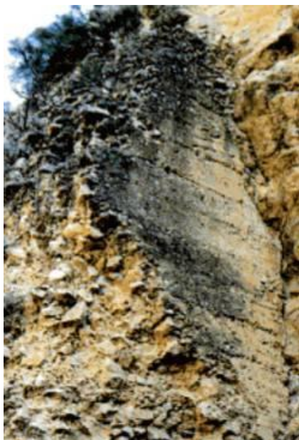
18- Presa de Malpasillo. Restos del estribo derecho en el que se observa el calicanto y las marcas del encofrado de madera [Díez-Cascón 2001: 61]
