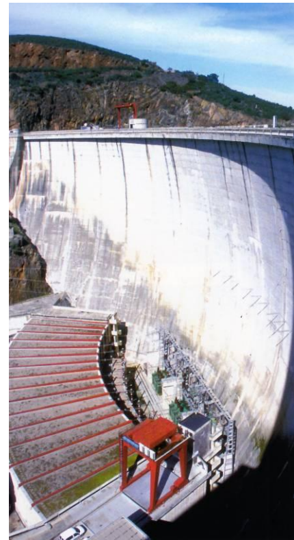
43- Presa y central de Valdecañas, curva cóncava y curva convexa [Aguiló 2005: 94]
