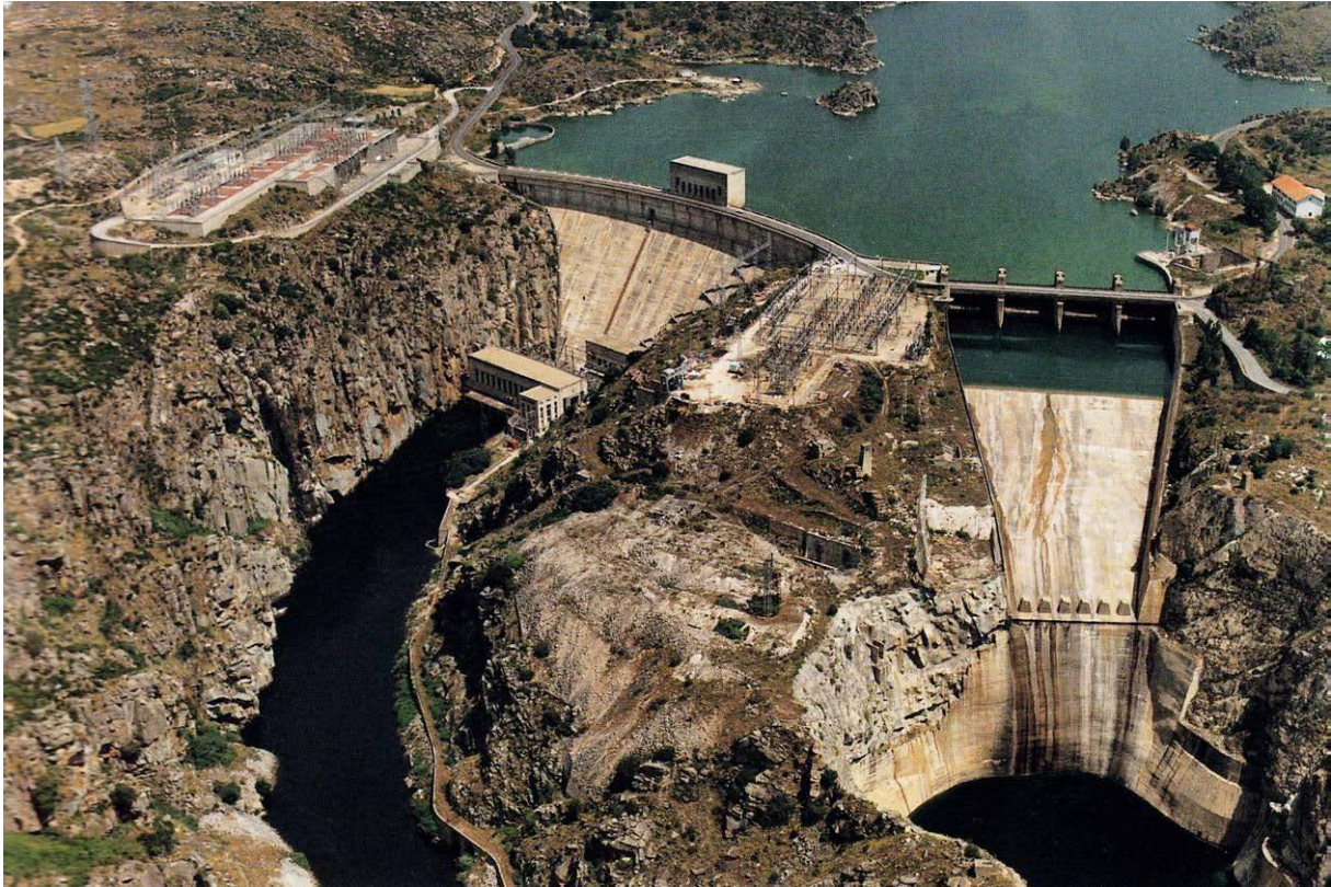
33- Presa de Ricobayo, con el aliviadero a la derecha [Buil y Gil 2008: 169]
