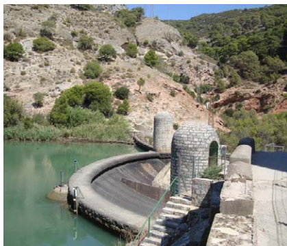
75- Pesa de Gaitanejo, vista del aliviadero aguas arriba [Aguiló 2005: 215]
