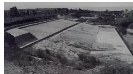
17- Vista aguas abajo del azud de Parada. Al fondo, la parte nueva; en primer plano, la parte medieval. [Schnitter 2000: 101]
