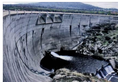
67- Presa de Almendra, vista general donde se pueden apreciar las presas laterales en las que se apoyan los estribos del muro principal [Baztán y Toledo 2008: 232]
