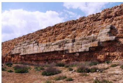
09- Intradós de la presa de Alcantarilla y sillería de recubrimiento. [Aeternitas Numismatics]
