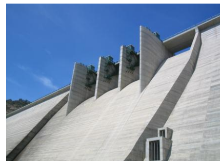
42- Presa de Rialb, detalle del aliviadero [Seprem]
