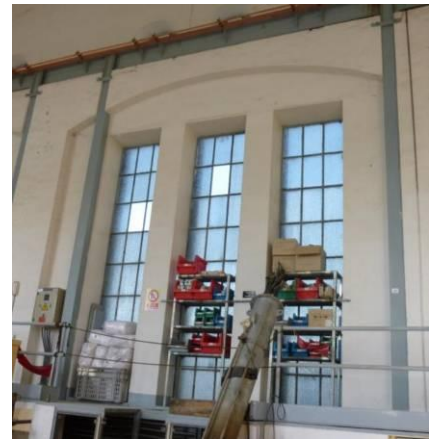
143- Arriba: refuerzos de la estructura original por el nuevo puente grúa
