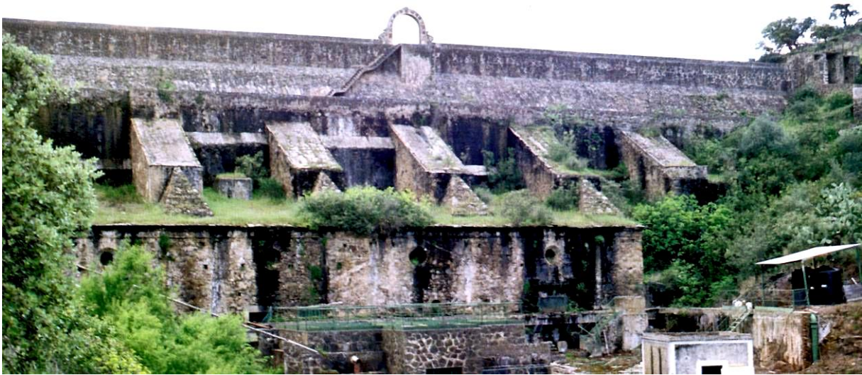
21- Albuhera de Feria, vista aguas abajo, con los contrafuertes y los molinos entre ellos [Aguiló 2005: 42]
